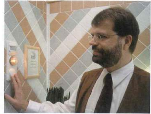
Auf Tastendruck Musik und eine Stimme erklärt das Bad – Heinz Hasenkamp demonstriert seinen „Märchenschalter“. Darüber: Leuchte und Bewegungsmelder.
